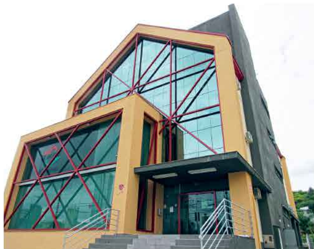
Prédio que abriga a sede da Ampe Blumenau, localizado na Rua Humberto de Campos, nº 245, no entorno do Parque Vila Germânica
